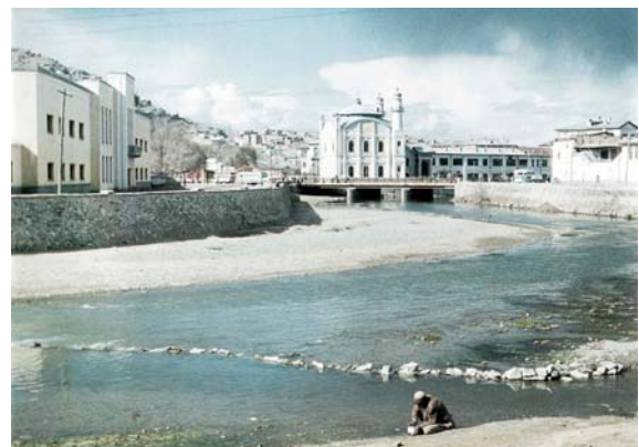
تصویر 12 : هدایت آب دریای کابل به باغ های داخل شهر،
