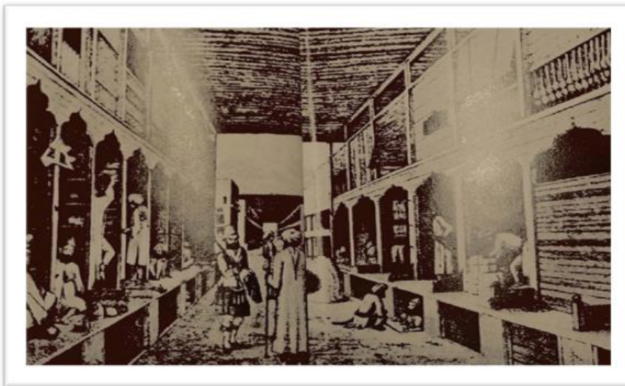
نمای داخل چارچته کابل*
