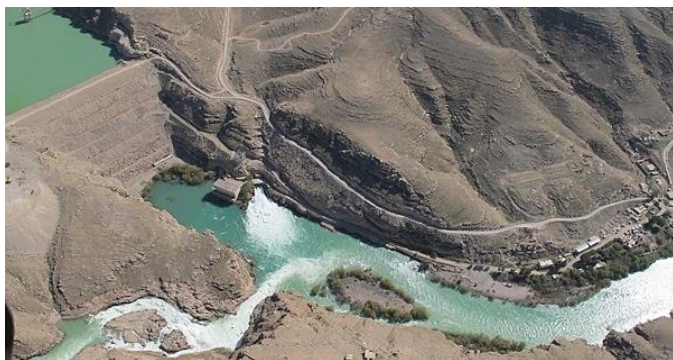
نمایی از دستگاه تولید برق کجکی در دامنه پایانی پرچاوه بند
