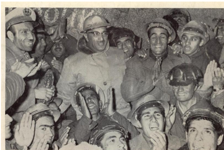
Seine Majestät der König (mit Brille) wird begeistert von den Männern des Arbeitskorps anlässlich des erfolgreichen Durchstoßens des Hindukusch-Gebirges zur Verbindung der beiden Teile des Salang-Tunnels begrüßt.
