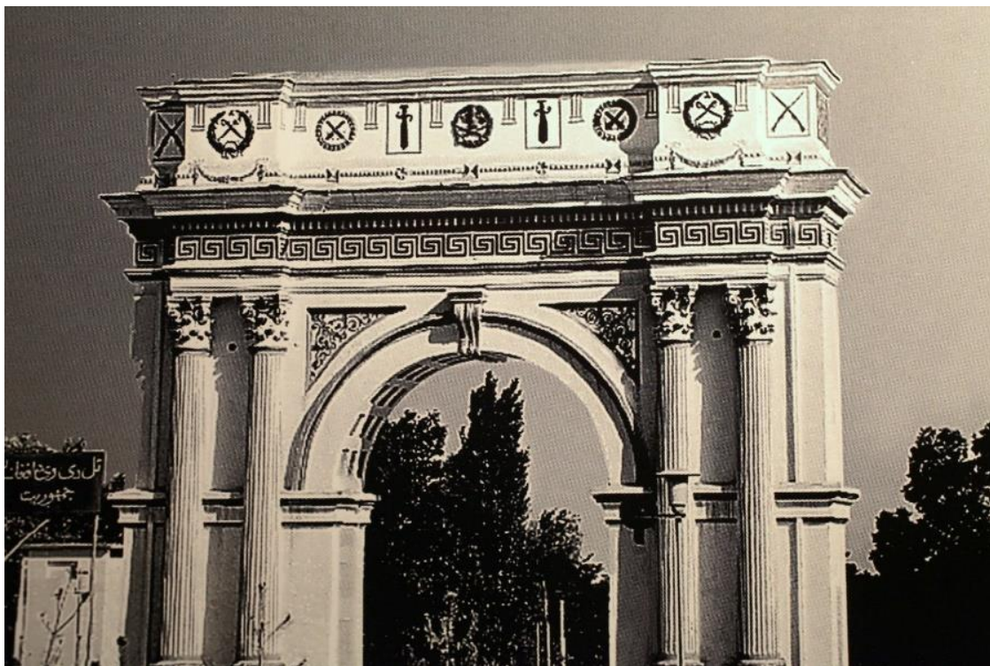
نمای موجود "طاق ظفر" پس از بازسازی و نصب سمبول های تزئینی بجای کتیبه تاریخی
